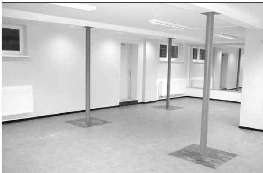
Ein Blick in das fertig gestellte TG-Studio unmittelbar vor dem Umzug der Geräte.
