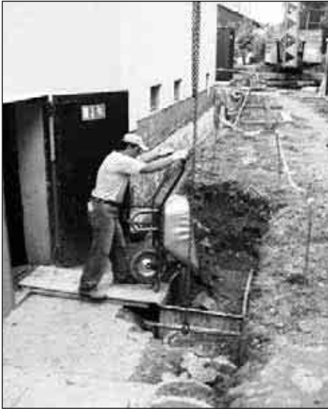
Die Aushubsarbeiten sind schon in vollem Gange.
