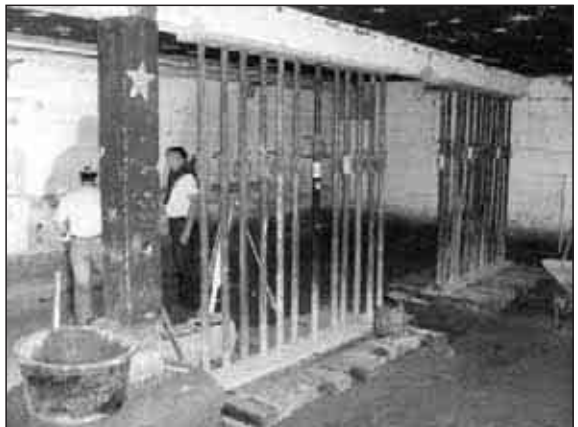
Vor dem Ausbau der alten Betonstützen muss die Decke abgestützt werden.
