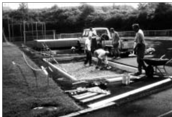
Einbau der Randsteine für die neue Weitsprunganlage im Sportzentrum durch die Helfer der Leichtathletikabteilung.
